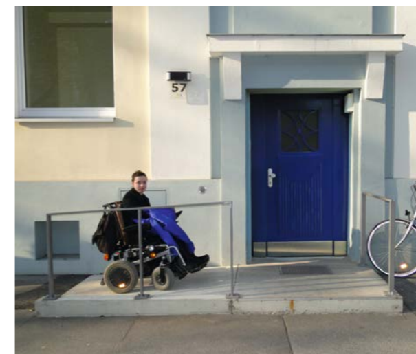
Eine flache Betonrampe ermöglicht die Benutzung des Eingangs auch für Menschen, die auf einen Rollstuhl oder Rollator angewiesen sind.
