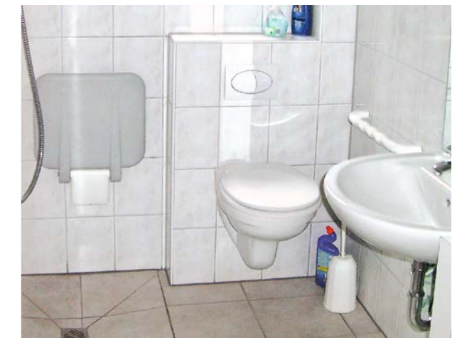
Nachher: Durch den Umbau wurde Bewegungsfreiheit geschaffen.
