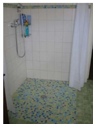
Bodengleiche Dusche statt Duschkabine: ca. 5000 €
