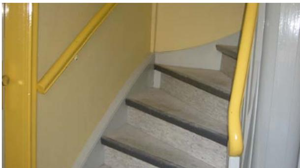
*Eine Treppe sollte über zwei Handläufe und kontrastreiche Stufenkanten verfügen.*
