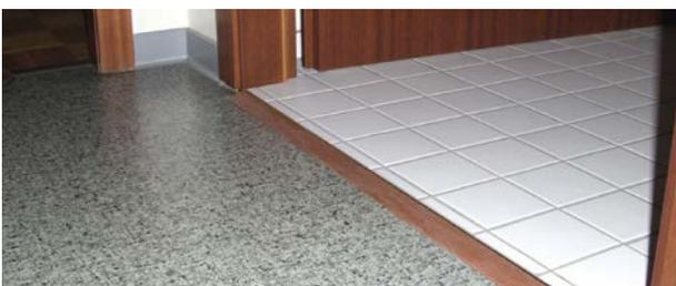
*Niveauunterschiede können mit Schwellenkeilen ausgeglichen werden.*
